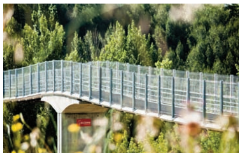
Construcción. Copyright : Acciona Infraestructuras/ JEC Innovation Awards.
