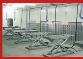
Instalación de cabinas en línea para varios puestos de trabajo
