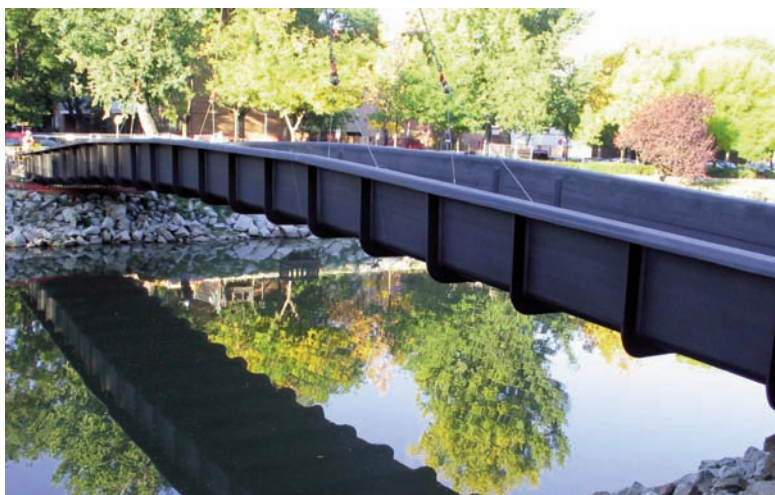
Viga puente de Acciona.
