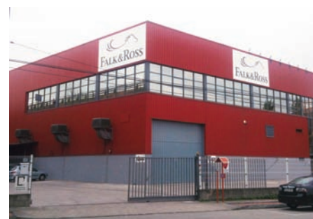
La nave cuenta con todas las instalaciones, muelles de carga, altura de más de 10 m.
