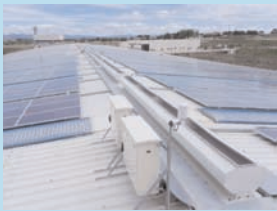
La nave 8 del CIM El Camp estrena cubierta fotovoltaica
