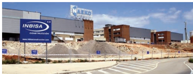
Las dos plantas del edificio se utilizarán para el almacenaje de los productos que Naeko gestiona para sus clientes, por lo que deberán soportar cargas hasta 3.000 kg/m 2 .
