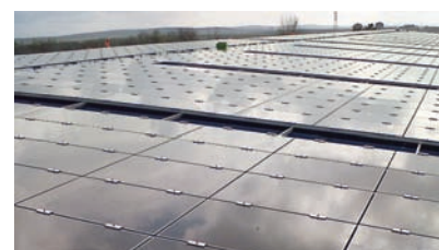
Placas en el proyecto 'Guadalquivir'.
