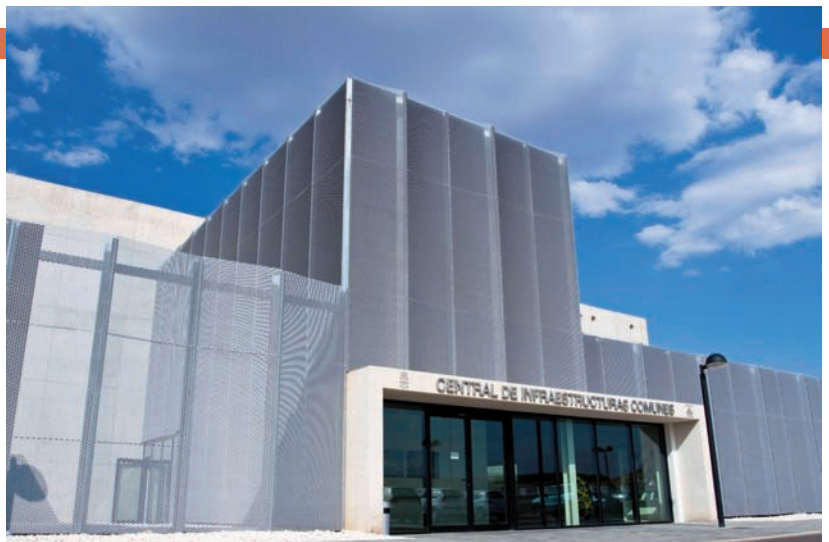
El corazón de la Ciudad Agroalimentaria de Tudela es la Central de Infraestructuras Comunes, dónde además de la Generación Térmica y la Generación Frigorífica, se aloja la Central de Trigeneración.
