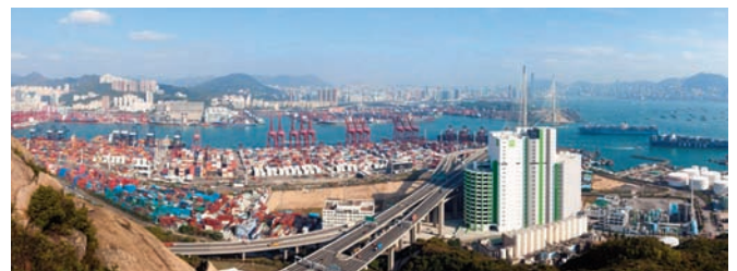
Ubicado en el centro de Tsing Yi, al lado de la terminal de contenedores 9 y del Stonecutter's Bridge, Interlink se beneficia de una posición estratégica junto al puerto de contenedores de Hong Kong, el aeropuerto internacional y las principales autopistas que conducen a China.
