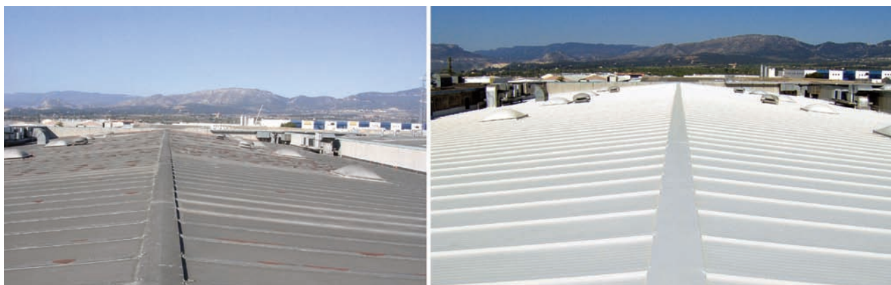
Una cubierta antes y después de aplicar Lotumcoat Therma RG.
