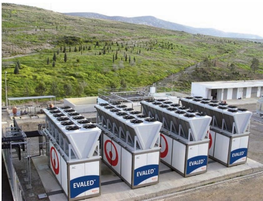
La gama de equipos Ehaled permite el tratamiento eficaz de efluentes industriales difíciles de depurar con tecnologías convencionales.
