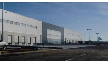
Nave Logística en alquiler. Logístic Park Barcelona Sur – La Granada del Penedès. Nave Logística de nueva construcción. Planta baja 9.734,50 m² / Oficinas 1.286,50 m². 10 muelles de carga, 2 rampas de acceso y altura interior libre de 10 m.
