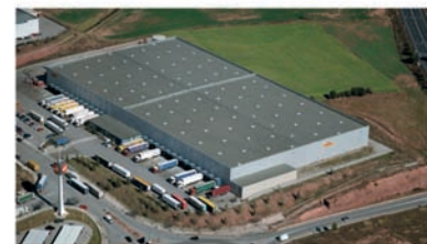
Nave logística en alquiler. PI Pla de Santa Anna. Zona Manresa. (Sant Fruitós del Bages) Nave 20.600 m² / 24 muelles de carga / 500 m² oficinas / altura libre 10 m / amplio patio frontal
