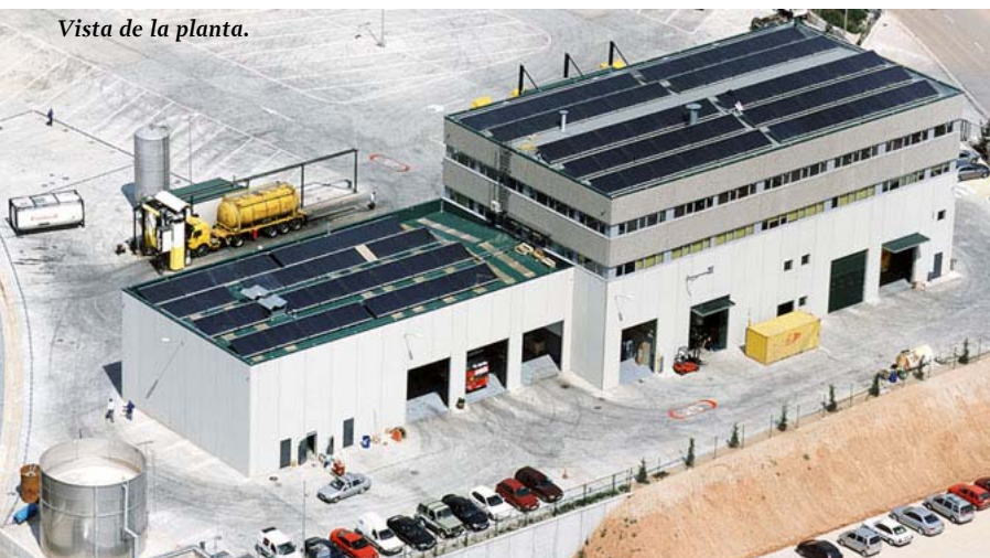
El campo solar está formado por 92 captadores solares de tipo módulo grande, de 5,54 m 2 de absorbedor, en 4 filas de 8 y 5 filas de 12 captadores, conectados en serie.
