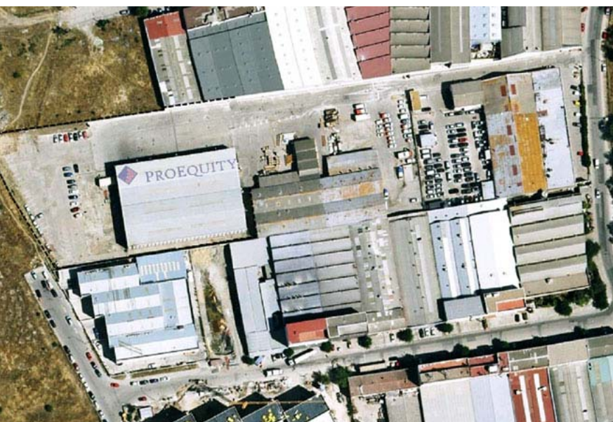
El inmueble cuenta con una superficie construida de 2.500 m 2 y una parcela de más de 8.000.
