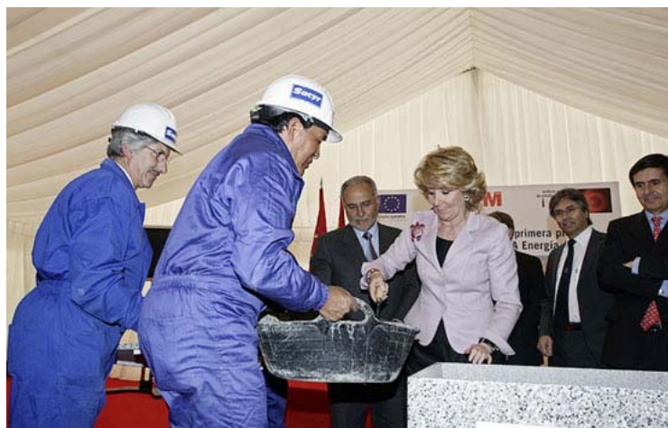
La presidenta de la Comunidad de Madrid, Esperanza Aguirre, colocó la primera piedra de la nueva sede de Imdea Energía.
