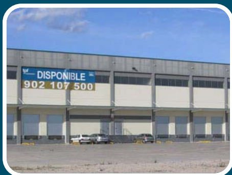
Nave logística de 11.000 m2 1ª LÍNEA A-3
