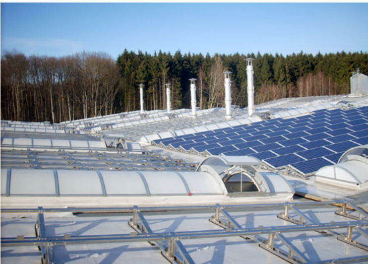
Cubierta de nave industrial parcialmente montada.
