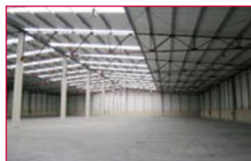
JUNDIZ - C/ LERMANDABIDE Pabellón ideal para logística distribución. 10.000 m 2 . Altura máx. de luz: 9,94 m. Con cinco muelles de carga y rampa. EN ALQUILER
