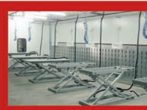
Instalación de cabinas en línea para varios puestos de trabajo
