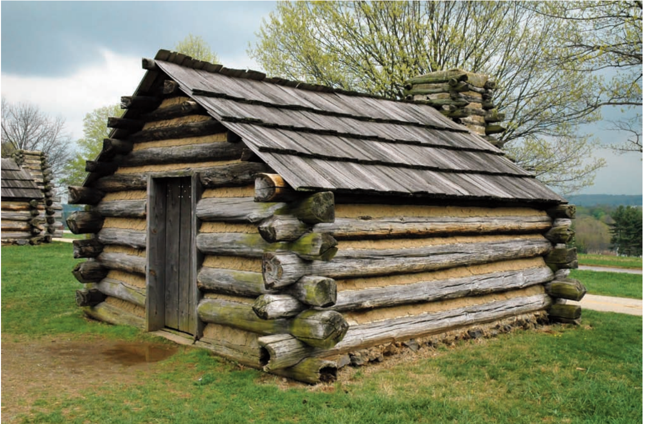
Cabaña de troncos, uno de los sistemas de construcción de viviendas en madera más antiguos.
