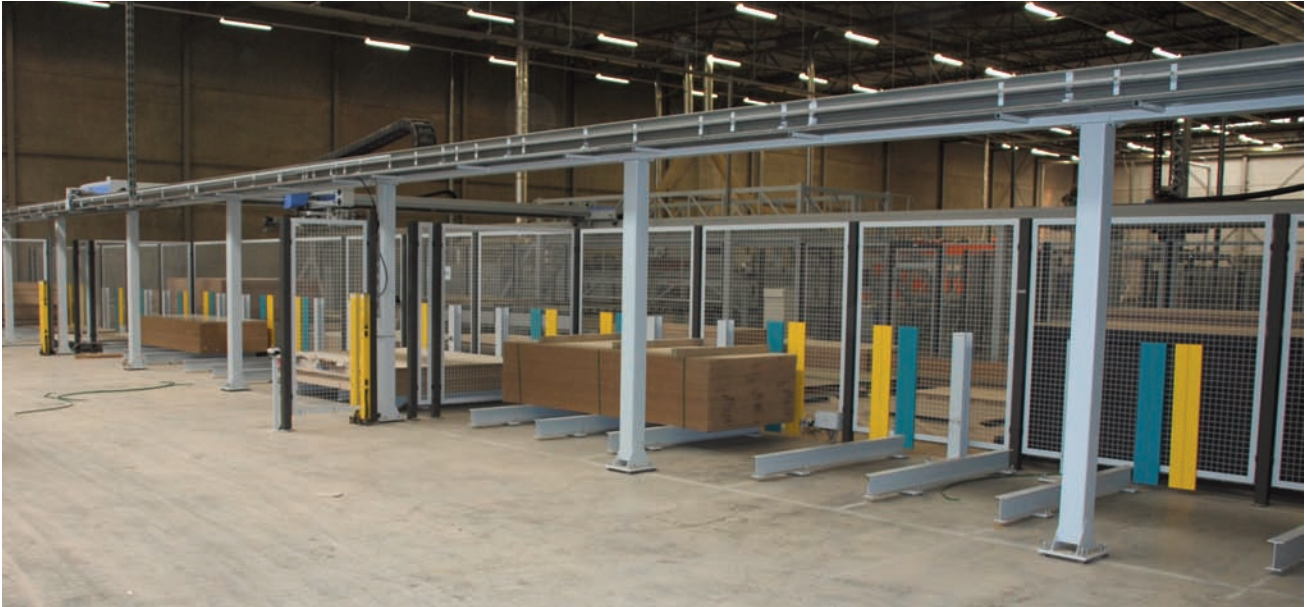
Los paquetes de paneles de gran formato se depositan en la parte posterior del almacén mediante un pórtico con nueve estaciones de almacenamiento.
