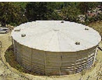
Los depósitos prefabricados Paver constituyen una alternativa a los depósitos tradicionales en hormigón armado tanto circulares como rectangulares con o sin cámaras divisorias. Existen dos familias de depósitos diferenciadas por su tipología estructural, denominados Depósitos Tradicionales y Depósitos Agri:
