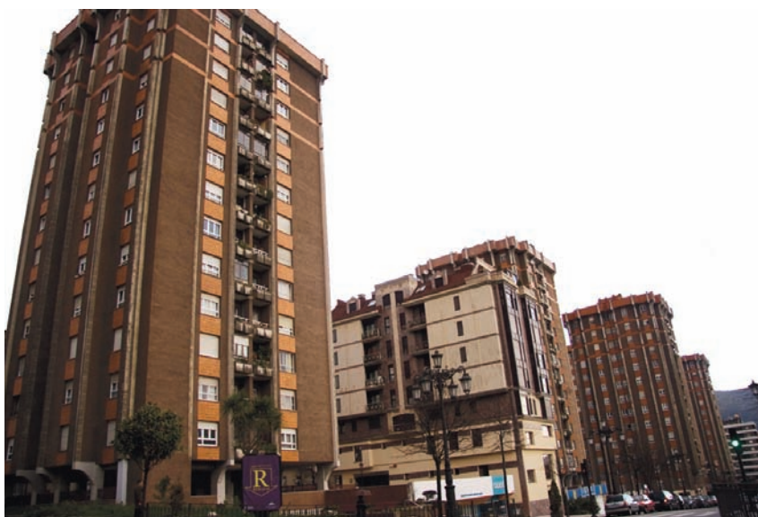
Son muchos los edificios que ya cuentan con calderas de biomasa, por su rendimiento y su precio económico.
