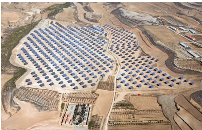
Parque fotovoltaico de Ríos Renovables en Fustiñana (Navarra).
