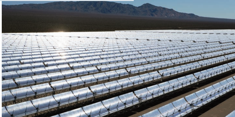
Planta termosolar de Acciona Energía en Nevada
