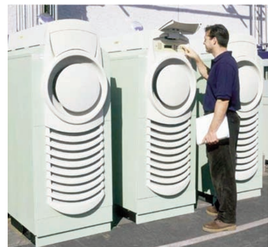
Figura 2: ejemplo de 3 microturbinas trabajando en paralelo. Fuente: Cortesía de Capstone Turbine Corporation
