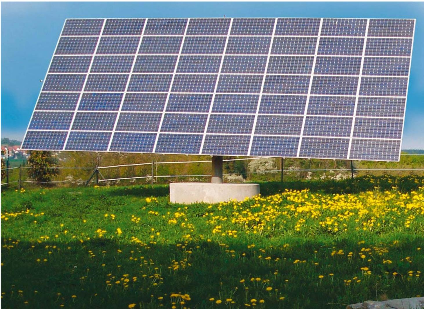
*El sensor DEGERconectar mide constantemente la intensidad y el ángulo de incidencia de la luz y permite el posicionamiento de la superficie modular orientándolo donde irradia más energía.*
