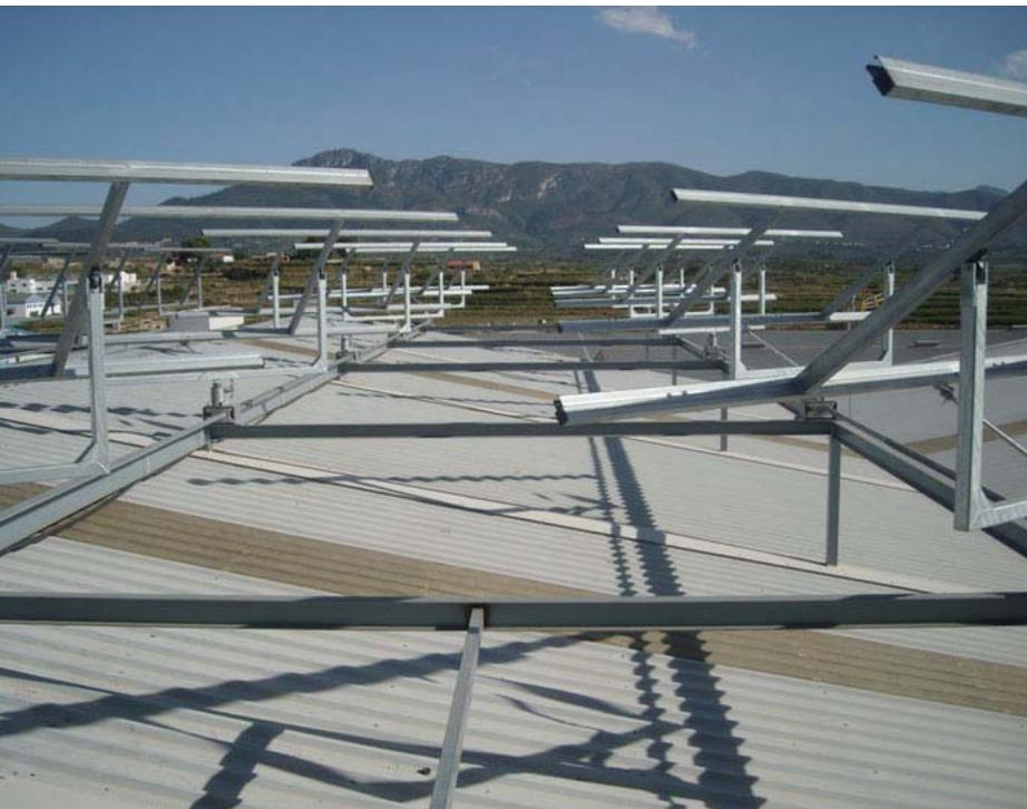
*Solartiva Mediterránea, empresa que fabrica, vende e instala seguidores solares para cubierta, ofrece un producto innovador para las cubiertas en el campo de las energías renovables. Se trata de un seguidor solar con seguimiento a dos ejes capaz de mover 80 paneles con un solo motor, lo que permite obtener una mayor rentabilidad con una menor inversión.*
