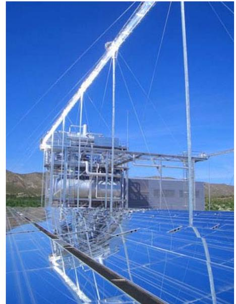
La técnica innovadora solar de Novatec utiliza menos material que las actuales tecnologías de energía solar térmica; la fabricación de los componentes del campo solar está muy automatizada y su instalación es sencilla. Además, la planta ocupa mucho menos terreno y utiliza menos agua que las plantas existentes, lo que permite una generación de energía de mayor rentabilidad y con menor impacto medioambiental.
