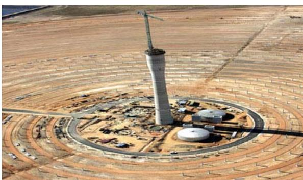
La planta está realizada con tecnología de torre central con receptor solar y helióstatos.
