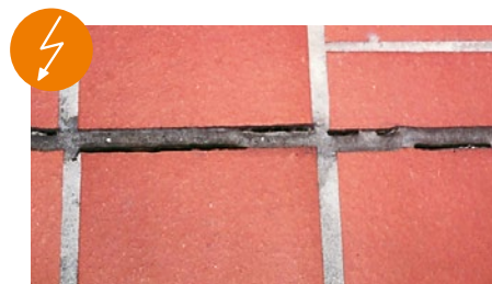
Patologías que se evitan con el uso de los perfiles de juntas de movimiento Schlüter®-DILEX
