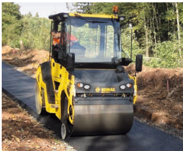
El rodillo BOMAG BW 141 AD, por sus medidas compactas, despliega todas sus ventajas sobre todo en la construcción de vías auxiliares.
