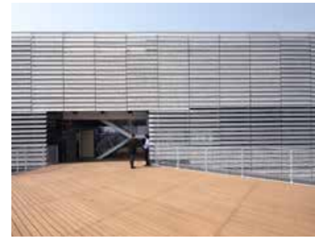
Vanke Center Shenzhen
