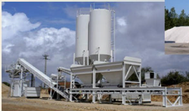
PACKLINER MH en obra
