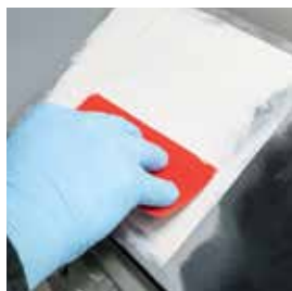
Aplicación de la masilla TEROSON UP 240
