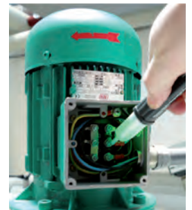
Reconocimiento de fase L2 e indicación del correcto sentido cíclico de las fases
