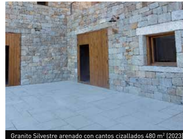
Granito Silvestre arenado con cantos cizallados 480 m 2 (2023)
