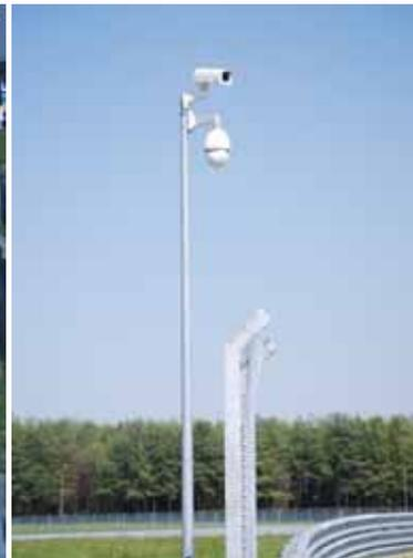
Su tutto il perimetro del circuito è stata posata fibra ottica che insieme agli switch di rete industriali completano l'architettura di collegamento dalle telecamere alla sala controllo garantendo un flusso dati costante anche su tratte così lunghe.
