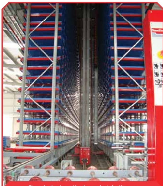
Ejemplo de ejecución de una instalación para almacenamiento de productos complementales en las unidades de carga.
