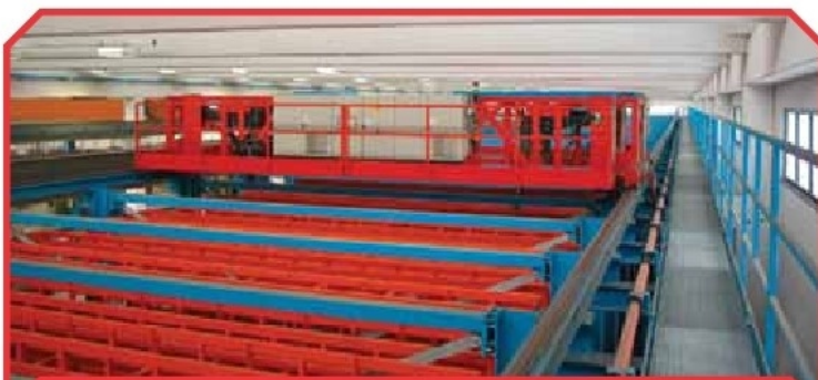
Detalle de la máquina: acceso para mantenimiento.
