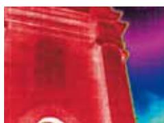
La imagen térmica puede revelar la construcción de una ventana oculta que es invisible a simple vista.
