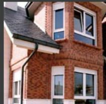
Las fachadas de las viviendas tienen dos partes claramente diferenciadas con valores de aislamiento muy diferentes, por una parte las paredes y por otra las ventanas, es evidente que son estas el punto más débil de la vivienda.
