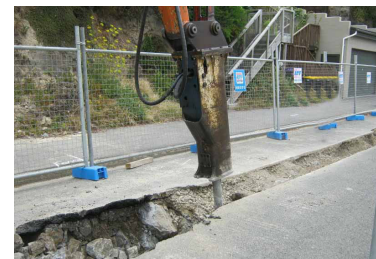
Excavación de zanjas, construcción de pozos, excavación de suelos
