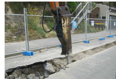
Excavación de zanjas, construcción de pozos, excavación de suelos
