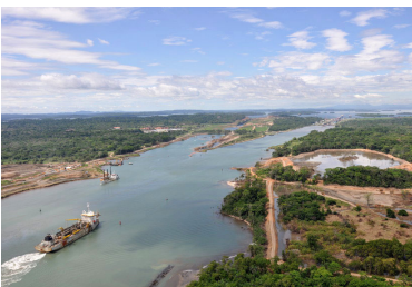
Profundización y ampliación de dársenas
