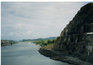
Profundización y ampliación de canales
