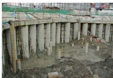
Conducción de pilotes para cimentación
