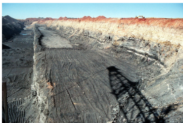
Desmante, nivelación de bancos, caminos y rampas
