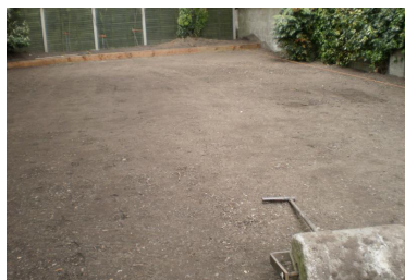
Nivelación de suelos
