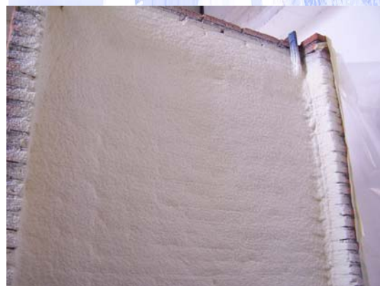
Estado de la muestra tras el ensayo, sin que se apreciaran penetraciones de agua.
