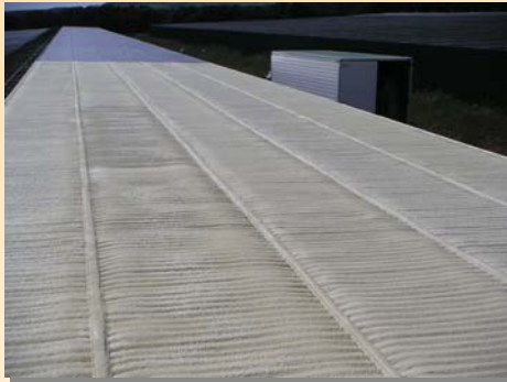
Cubierta de chapa aislada por el exterior, antes de aplicar la protección de la espuma
