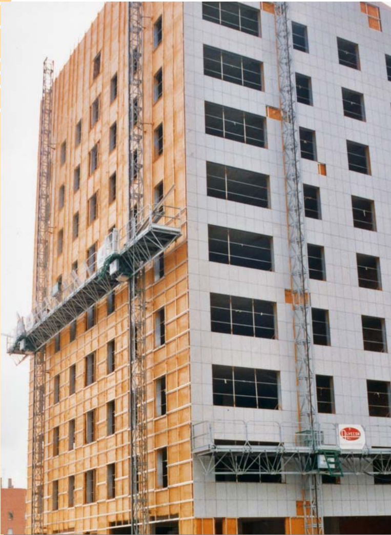
Fachada ventilada proyectada con espuma de poliuretano.
