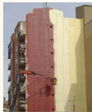
Proyección en medianera con protección
