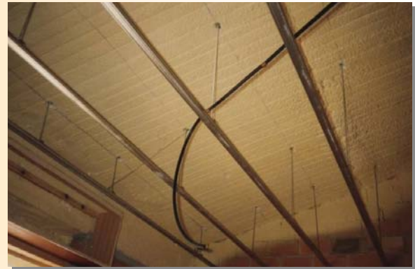
Es importante no dañar la espuma al colocar los soportes del techo.
