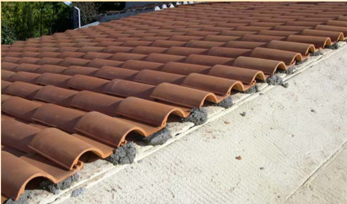
Cubierta de teja sobre pelladas, aislada con poliuretano proyectado
