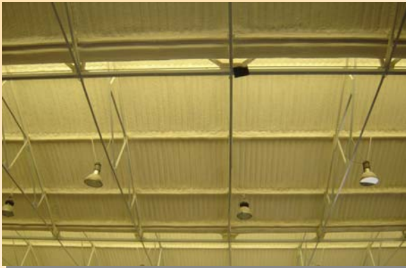
Cubierta de chapa aislada con poliuretano
