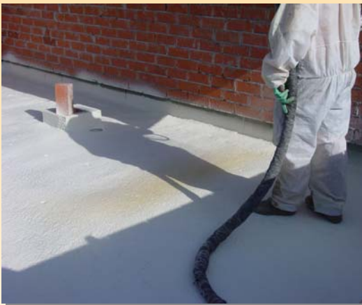
Cubierta transitable proyectada con espuma de poliuretano
