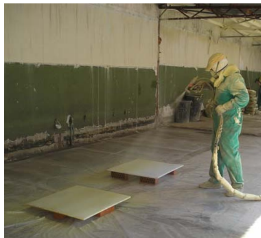
Aplicador proyectando muestras para realizar un ensayo externo de conductividad térmica.
