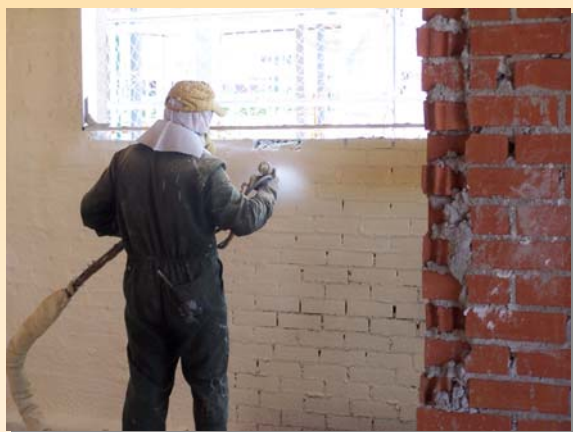
La proyección sobre ladrillo cara vista no requiere de enfoscado previo para garantizar la impermeabilidad
