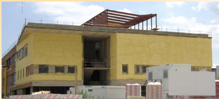
Proyección de poliuretano antes de recibir el revestimiento
