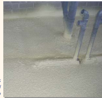
Tuberías e instalaciones quedan envueltas por el poliuretano proyectado
