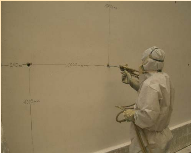
La inyección se realizará a través de orificios practicados en una de las hojas del cerramiento, siempre de bajo a arriba
