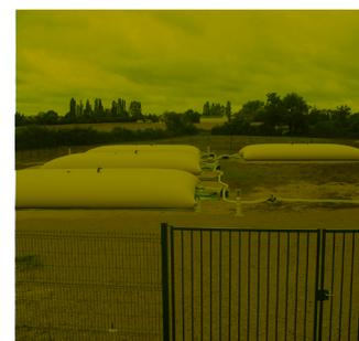
Las cisternas flexibles autoportantes se inventaron y aplicaron específicamente desde 1959 (más de 8.000 referencias) para el **almacenamiento de soluciones nitrogenadas y azufradas de larga duración.**
